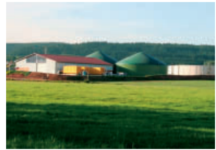
Betrieb von Biogasanlagen
