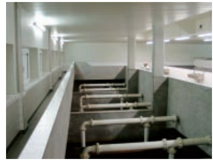
Sanierung einer Filterhalle
