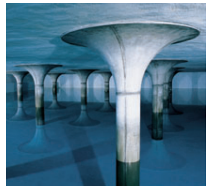
Ortbeton in Trinkwasserspeichern
