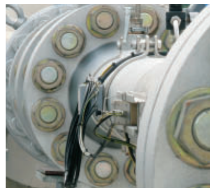
Clamp-On-Ultraschallsensoren messen von der „sicheren Seite“.
