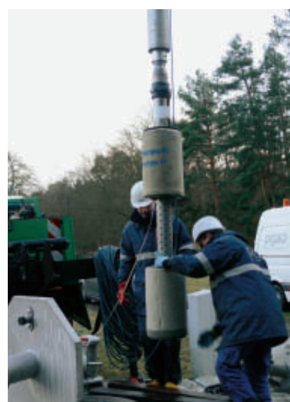
Doppelkolbenkammer zur Brunnenfilterentsandung
