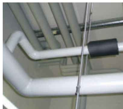
Trinkwasseranlage: Sanierung und Desinfektion
