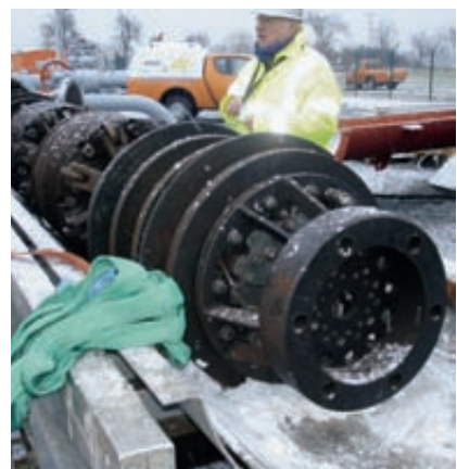
Molch-Einsatz in einer Gasleitung
