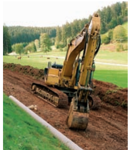
Bau einer Gashochdruckleitung
