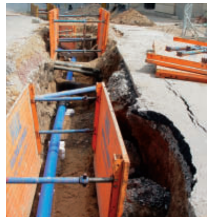
Vermeidung von Rohrleitungsschäden
