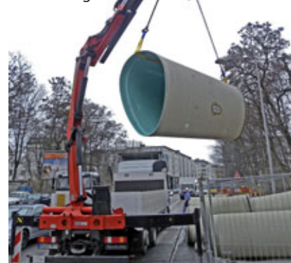
Rohrlager mit AMIREN-Eiprofilen an der Dufourstraße in der Leipziger Innenstadt.
