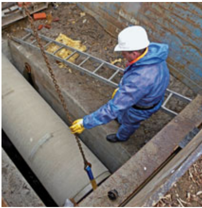
Ein Eiprofil wird in die Baugrube gehoben.
