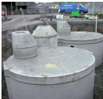
Das Regenwasserensemble mit Filterschacht und zwei Speicherbecken steht in der Baugrube.
