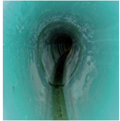
Der neue Sammler unter der Dufourstraße.
