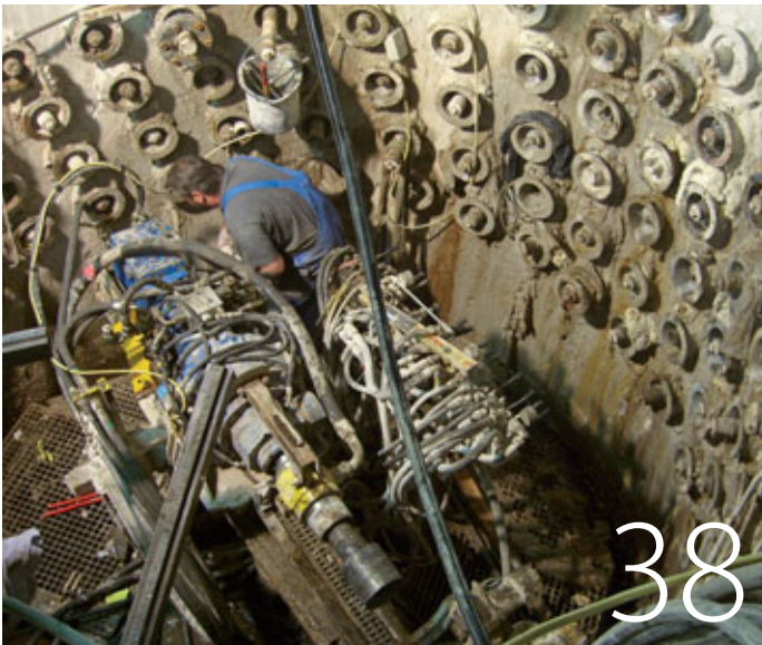
City Tunnel Leipzig: Injektionsbohrungen aus 13 Schächten sichern die Bebauung vor Setzungsschäden.
