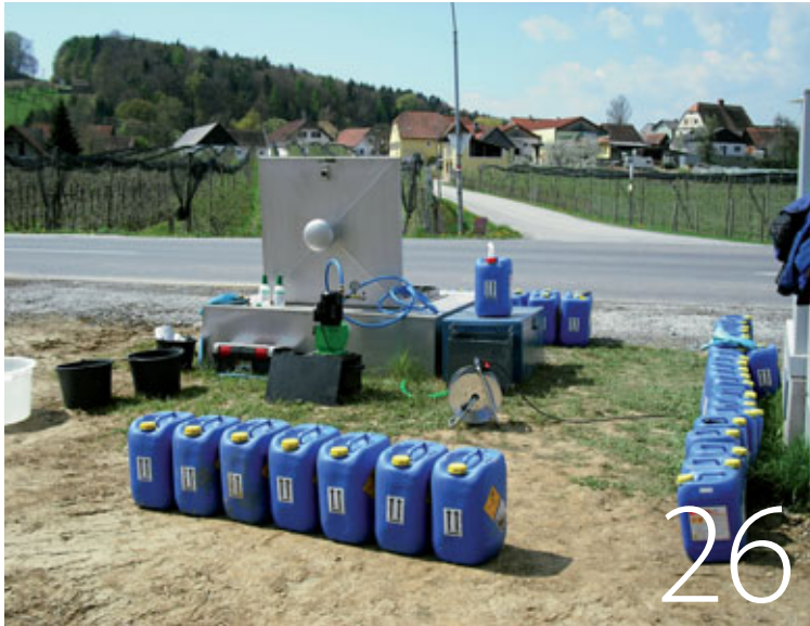
Die Entfernung von Biofilm in Rohrleitungen schützt vor Korrosion, Defekten und Verstopfungen.
