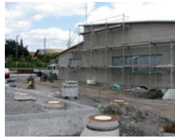
Baustellenreport | Bau einer Flächenentwässerung mit Abscheideanlage für Illinger Feuerwehr
