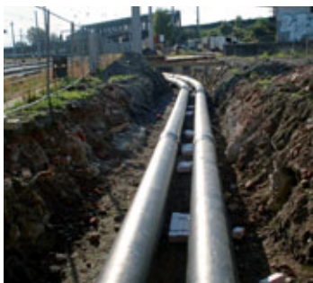
Eine logistische Herausforderung: der innerstädtische Bau von Fernwärmeleitungen.
