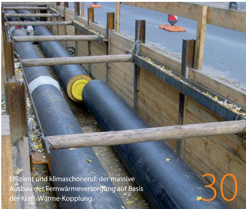
Eine logistische Herausforderung: der innerstädtische Bau von Fernwärmeleitungen.
