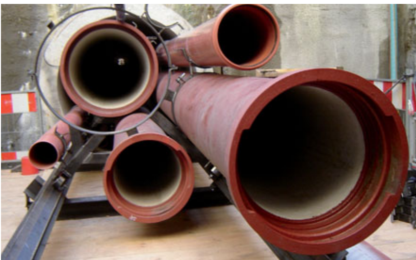
Abb. 1 Der größere Düker für die Kanalentwässerung: Durchführung mit Stahlrollenringen, die Stützweite beträgt 3 Meter. Nach dem Einzug erfolgt die Ringraumverdämmung.
