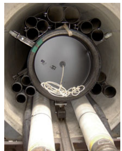
Abb. 2 Die Lösung für den nicht linearen Verlauf: eine aufwändige „Y-Konstruktion“ mit drehbarem Laufrad
