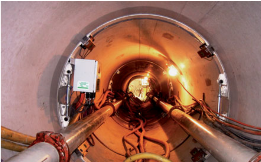
Abb. 7 Installierte Doppelmessfuge im Tunnel
