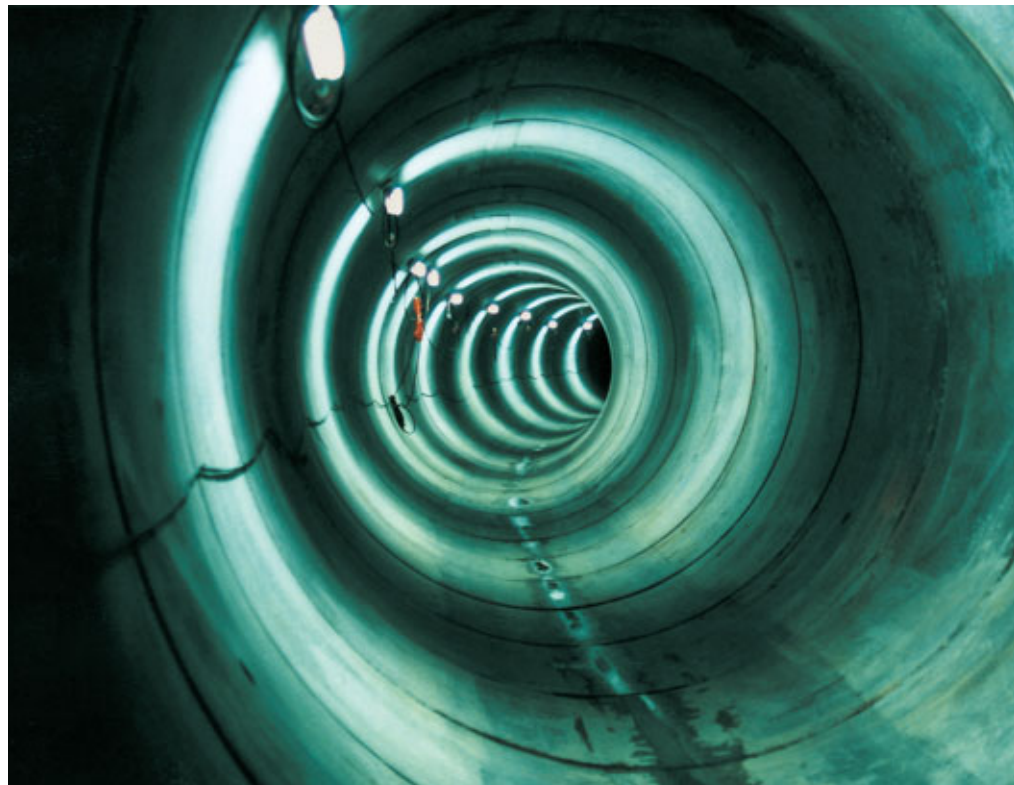
Abb. 1 Moderne Mess- und Steuertechnik ermöglicht die hochgenaue Steuerung beim Tunnelbau.
