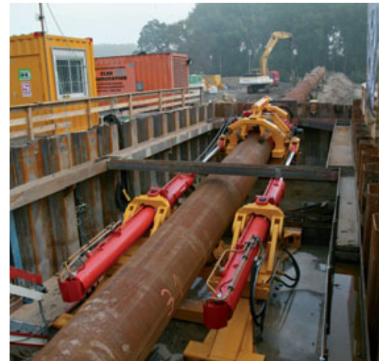
Abb. 9 AVN1000 Direct Pipe mit integriertem HGO in der Startgrube in Worms
