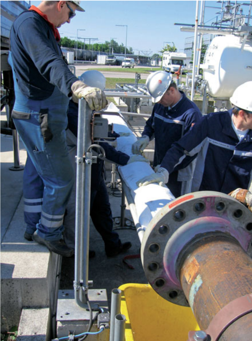
Abb. 3 Einschleusen eines Molches
