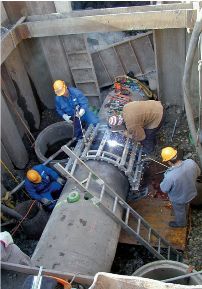
Abb. 7 Sanierung einer DN 1000 Leitung mit Hot Sleeves
