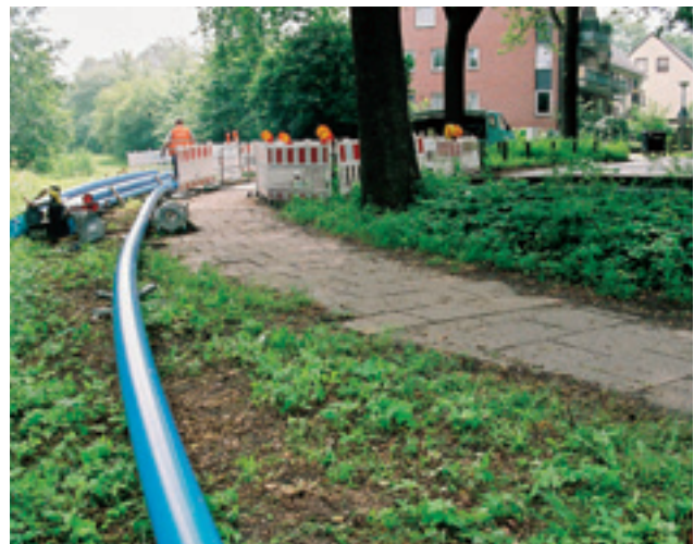
Bei der grabenlosen Leitungslegung werden zunehmend belastungsfähige PE-Rohre gefordert.
