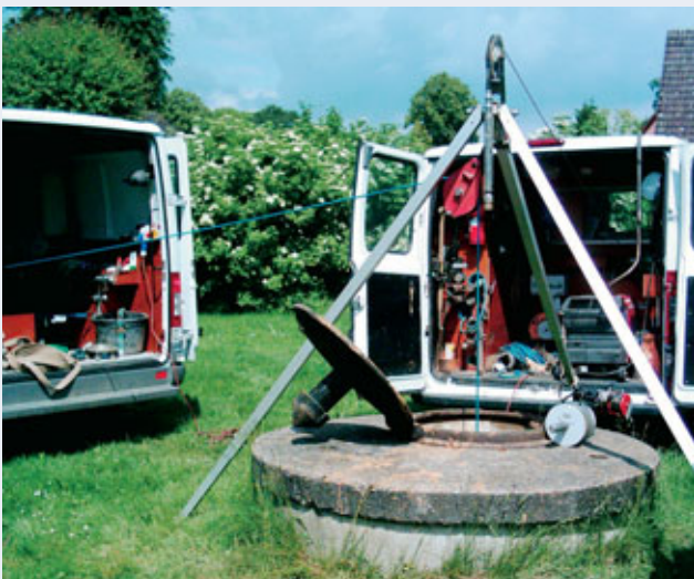
Bohrlochgeophysikalische Untersuchungen zeigen den Zusammenhang von fehlenden Tonsperren und einer verstärkten Verockerung der Filterkiesschüttung.
