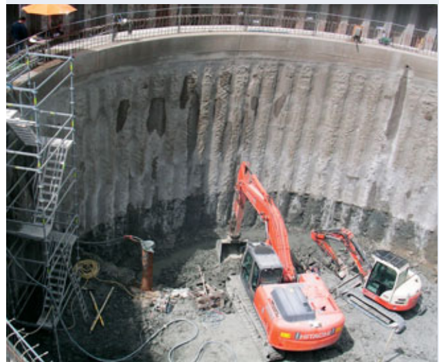
Große Schachtbauwerke dienen bei der Umgestaltung des Emschersystems als Ausgangspunkte für den (unterirdischen) Rohrvortrieb.
