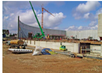
Im Chemiapark Marl wurden in kurzer Bauzeit chemisch und thermisch hoch beständige Rohr- leitungen verlegt.
