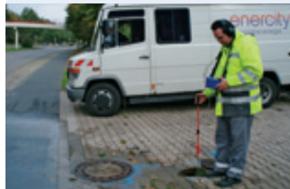
Akustische Leckortung am Hydranten
