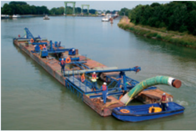
Unterdükerung im Einschwimmverfahren: Den Transport zur Verlegestelle übernahm ein Ponton in Katamaranbauweise. 36
