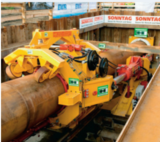
Mit dem Direct-Pipe®-Verfahren wurde ein beson- ders für die Verlegung großer Rohrdurchmesser vorteilhaftes Verfahren entwickelt.
